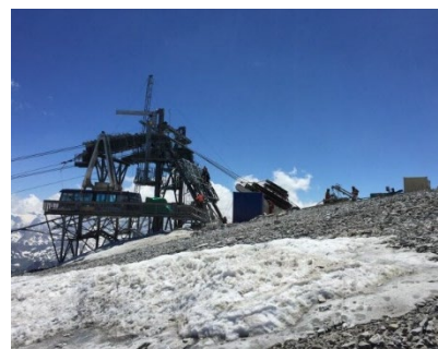
Tignes, renforcement du téléphérique de la Grande Motte
