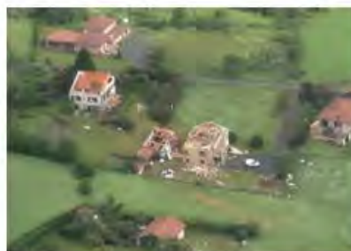
Tornade Alex, maisons isolées plus vulnérables
