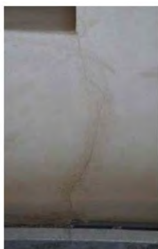
3.4.5. Fissuration d'un enduit chaux sur une isolation en paille
